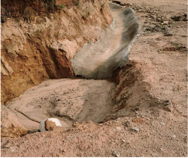
排水沟沉砂池
