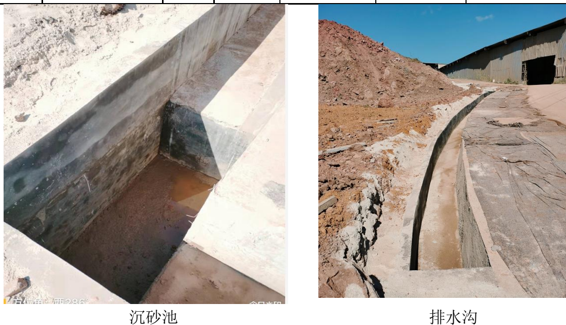
图 3-1 水土保持工程措施照片
