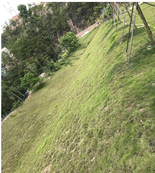
边坡防护区现状
