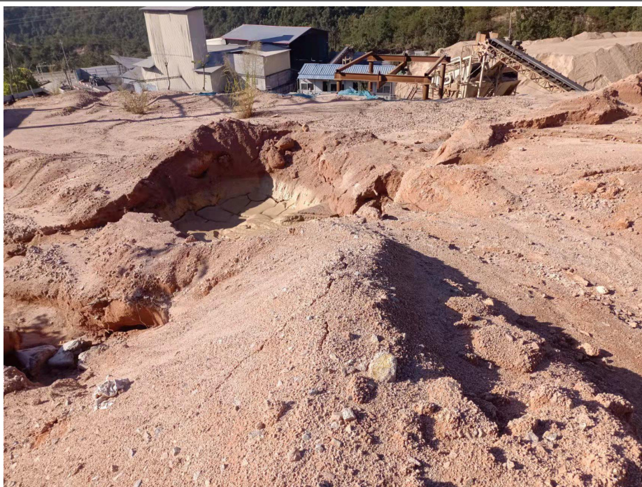
工业场地区现状
