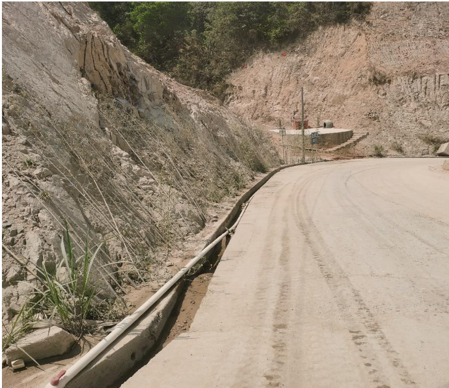
矿山道路排水沟
