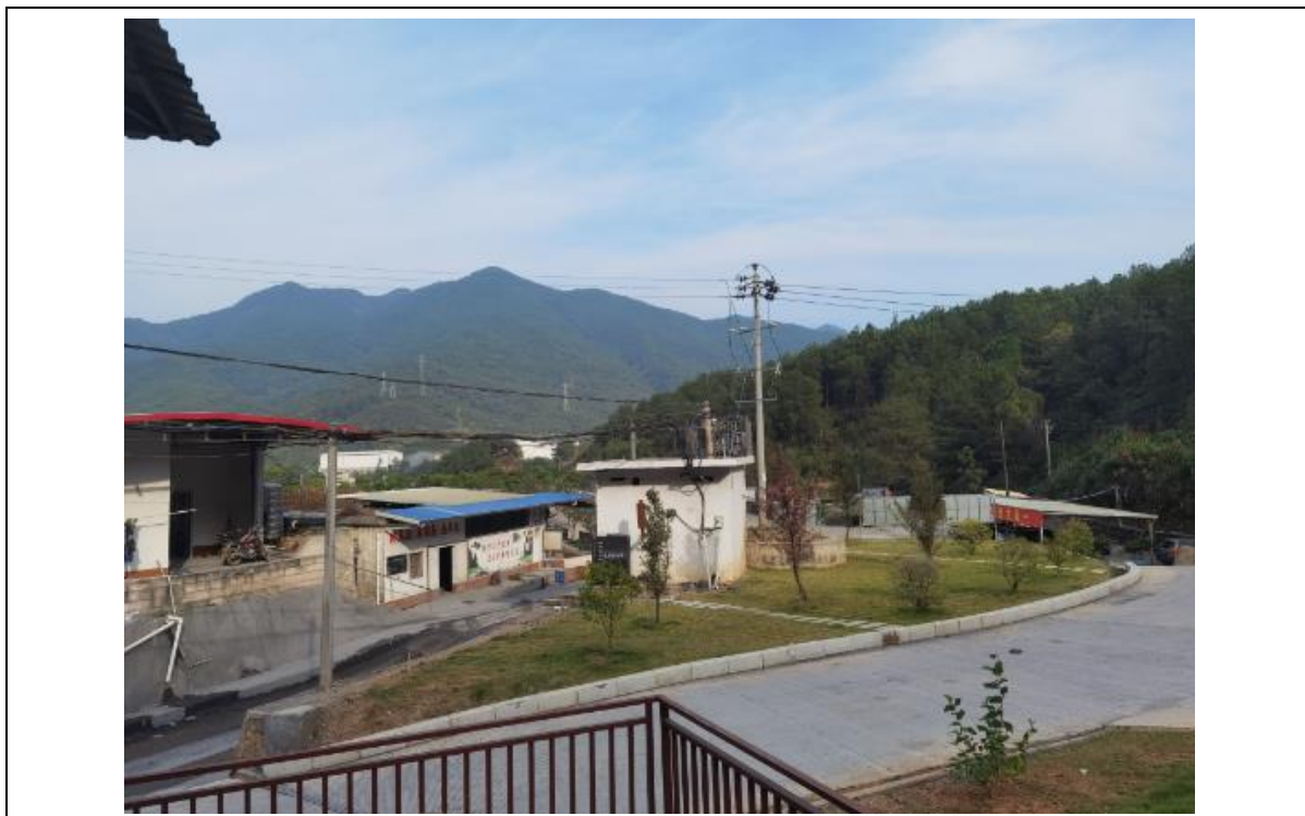
工业广场区现状
