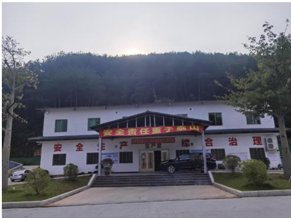
办公生活区现状
