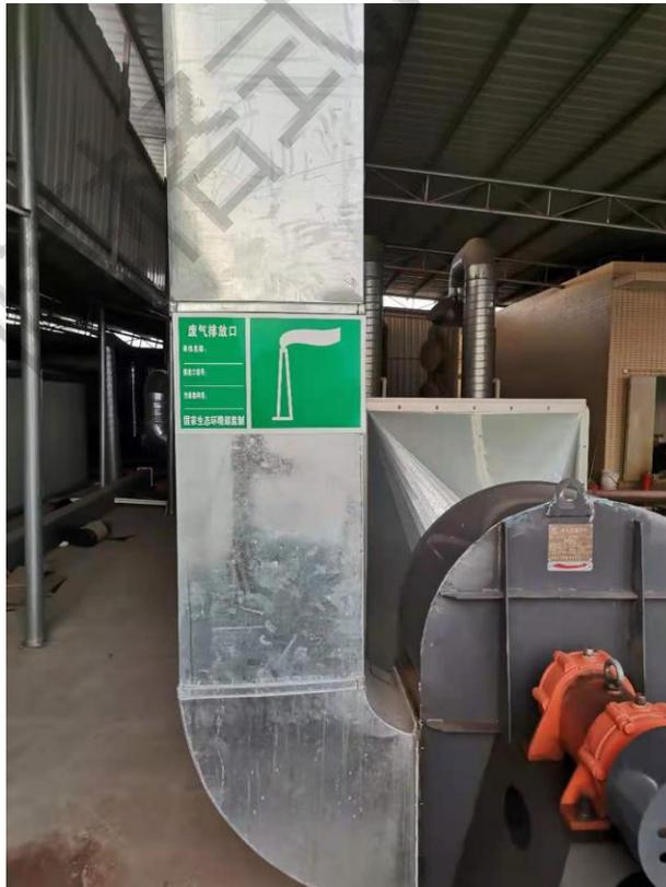
图2 1#厂房废气排放口（喷涂工序、流平烘干废气）
