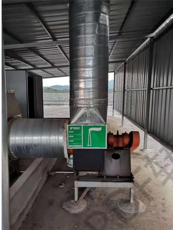
图1 2#厂房废气排放口（注塑、发泡、混料、破碎、打磨、丝印废气）
