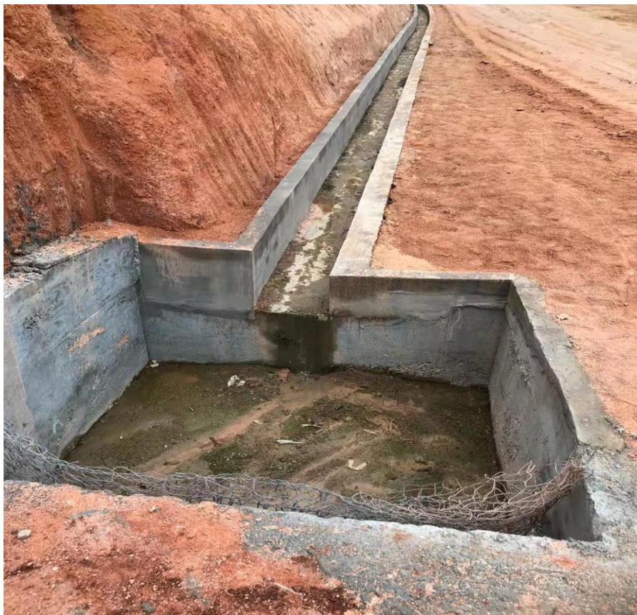
排水沟、沉砂池
