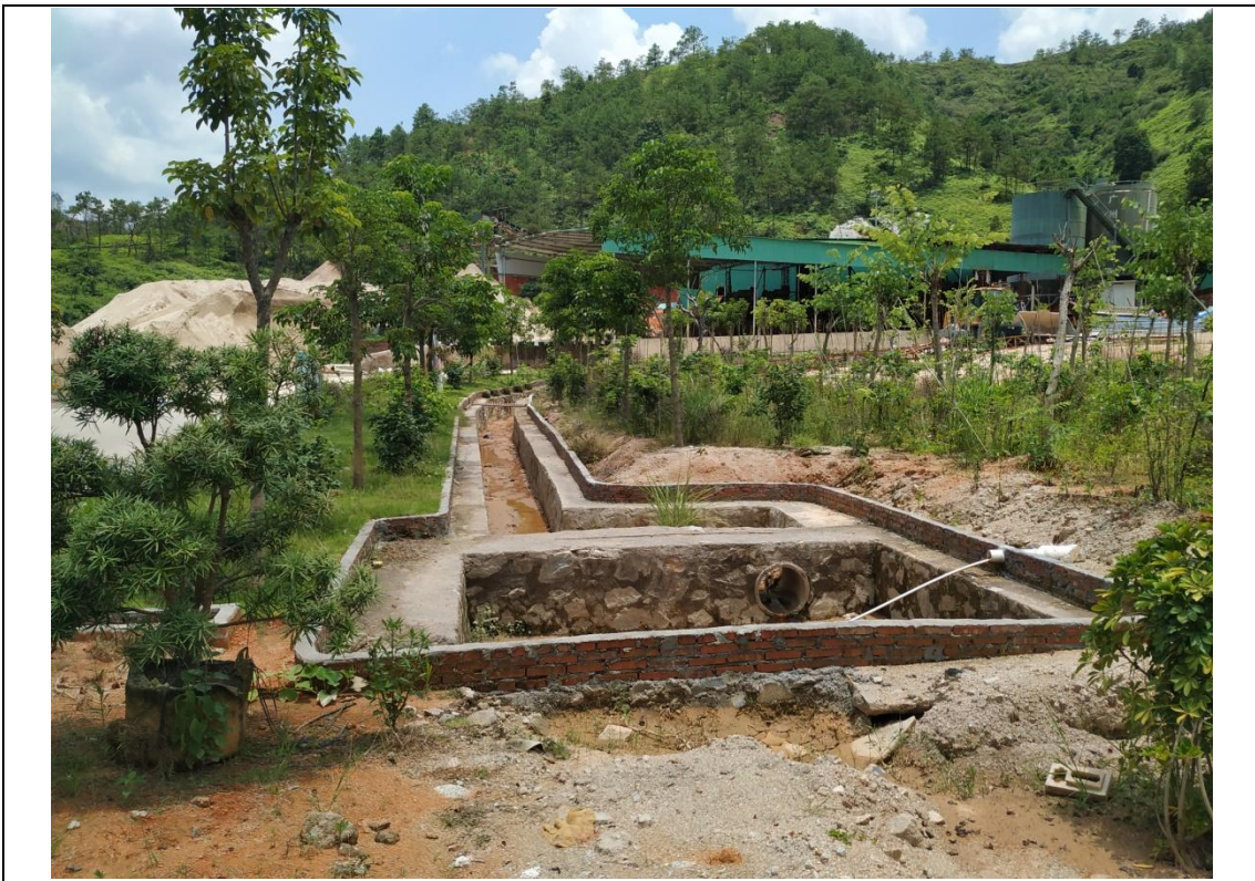
排水沟、沉砂池
