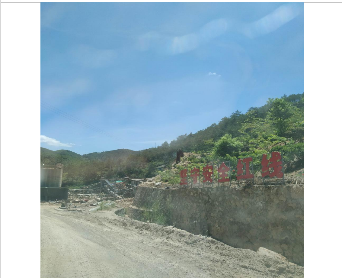
工业场地挡土墙、排水沟
