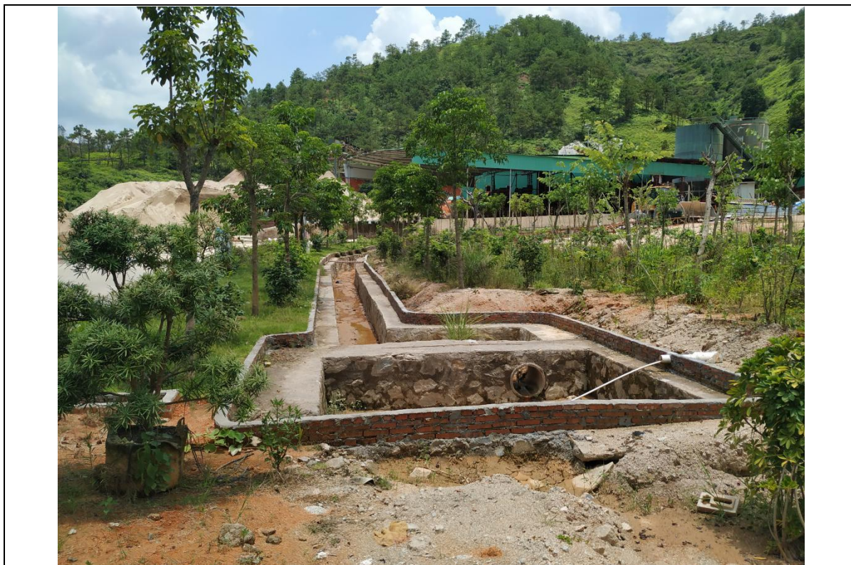
排水沟、沉砂池
