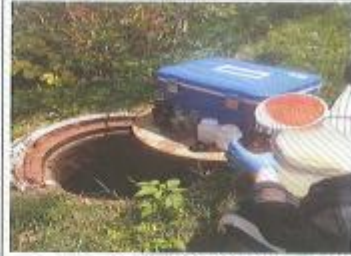
生活污水排放口
