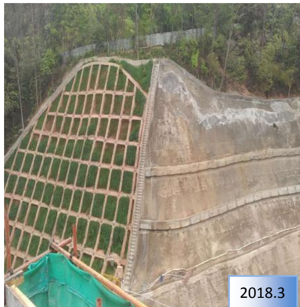
L7 栋边坡 (L 区二期东南面)
