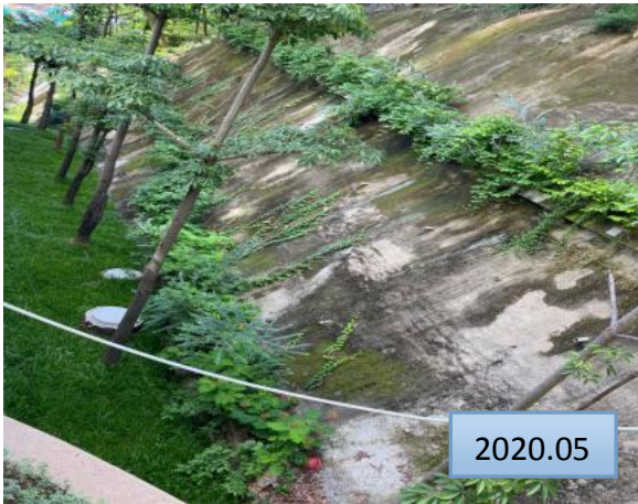
已完成的边坡及绿化
