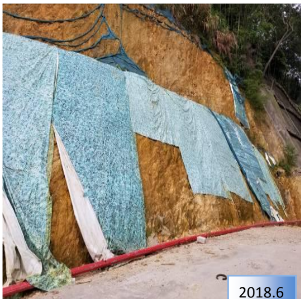
施工过程中开挖边坡
