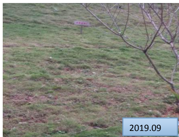
现状植草护坡。布设水土保持监测点
