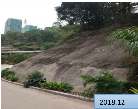
已完成的边坡支护
