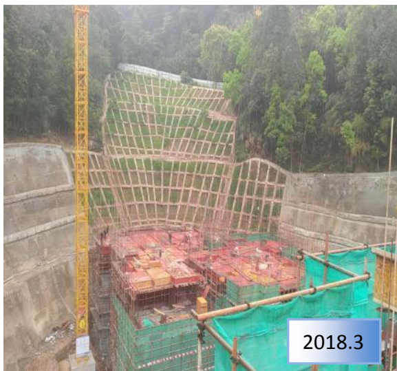
L5 栋边坡 (L 区二期西南面)
