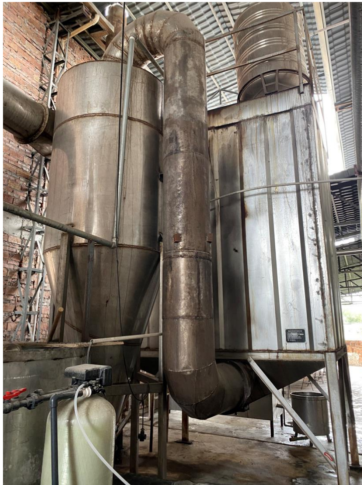
图 4.1-1 废气处理设施图
