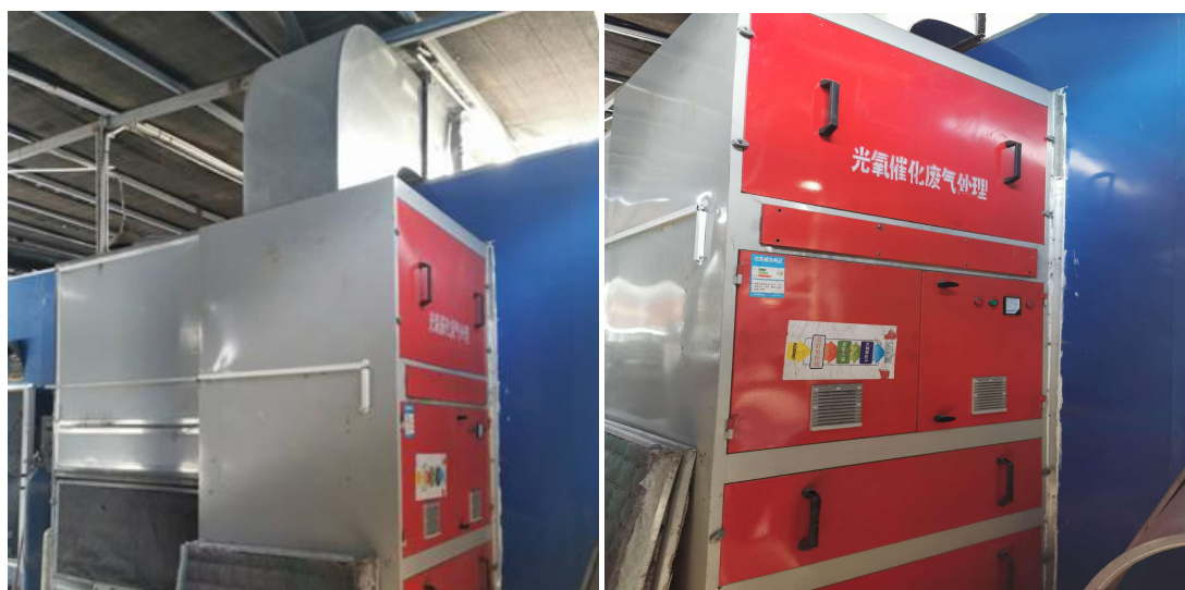
图 4.1-3 烤漆房“UV 光解净化器”设施
