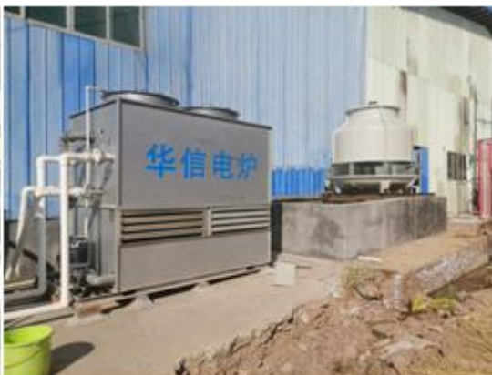
中频熔炉冷却系统
