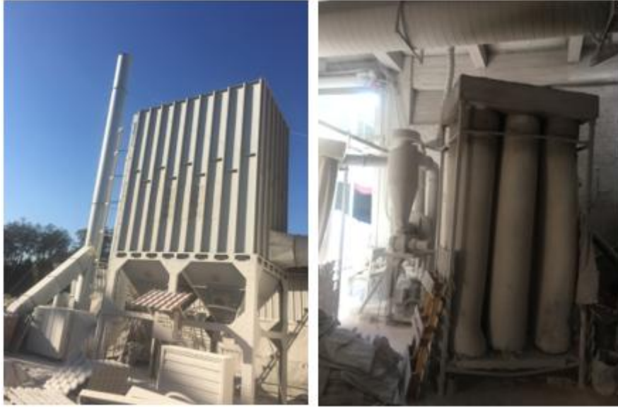
图 4.1-1 废气处理设施图
