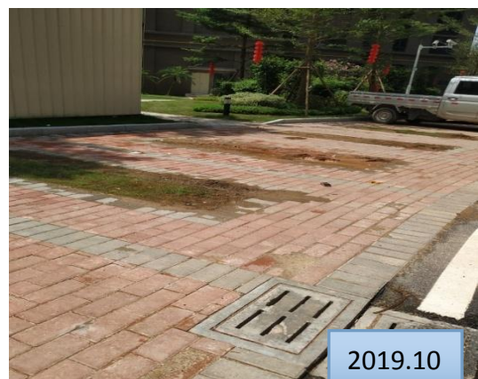
已完成的硬质铺地及雨水篦
