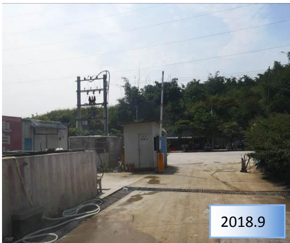
施工出入口车辆冲洗设施
