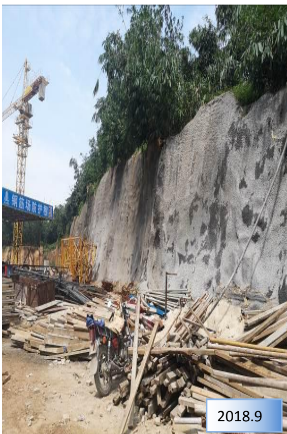
材料堆放场地，开挖边坡
