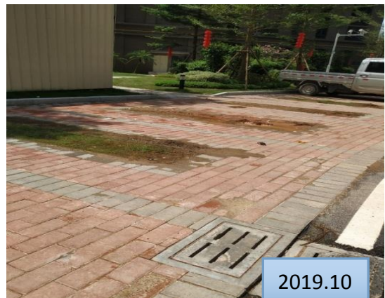
已完成的硬质铺地及雨水篦
