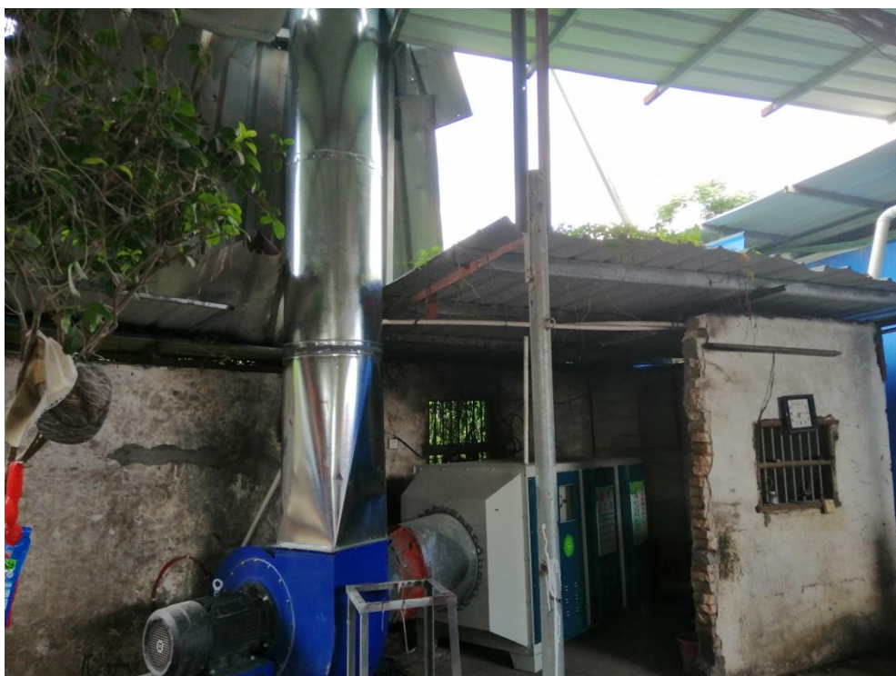
图 4.1-3 烤漆房“UV 光解净化器”设施
