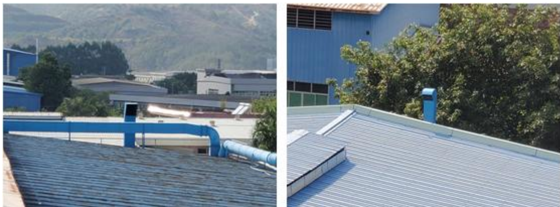
图 4.1-2 鞋面生产线有机废气处理设施及其排气筒图
