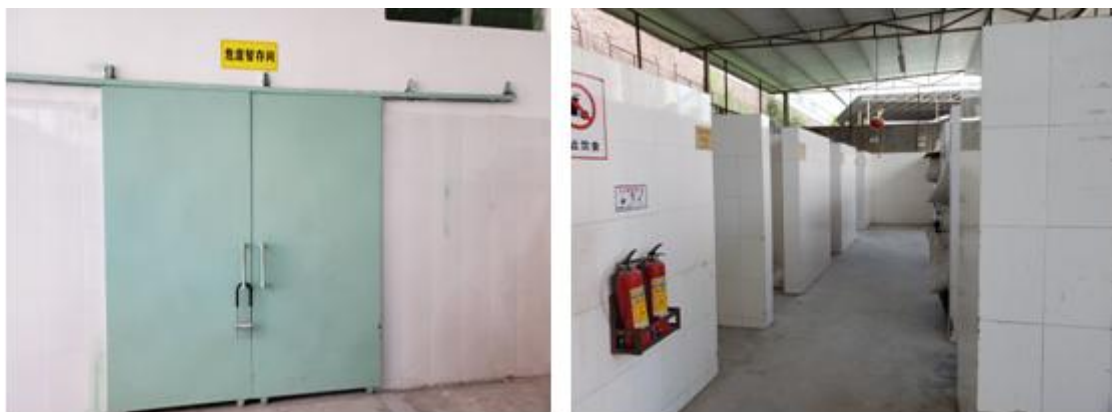
图 4.1-4 危废暂存间及一般固废存放间
