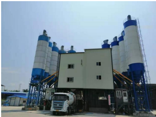
混凝土搅拌生产线
