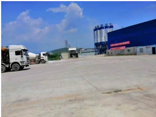
厂区道路硬底化
