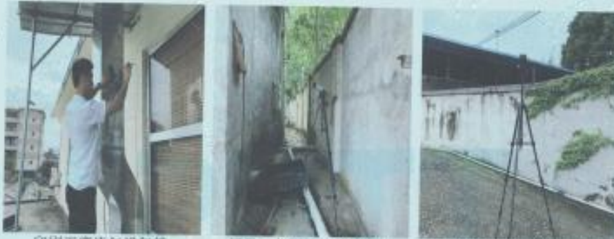
印刷工序废气排气筒
