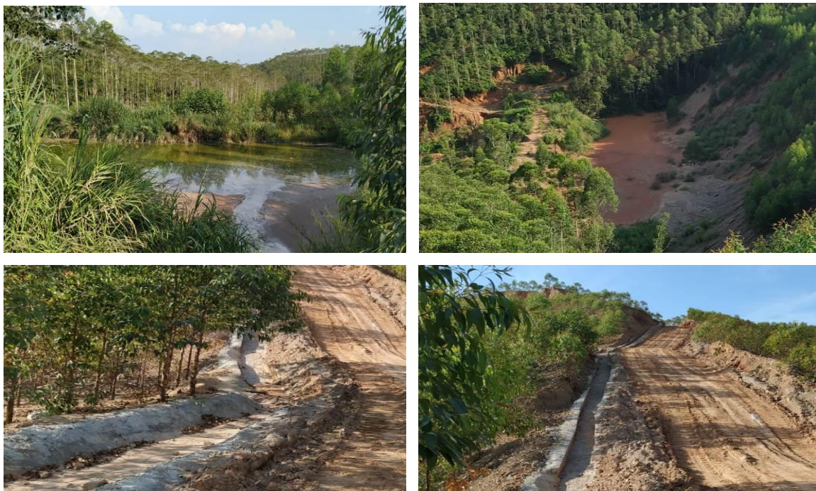
图 3-1 水土保持工程措施照片
