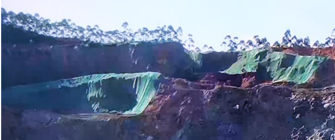
图 3-3 水土保持临时措施照片防雨布
