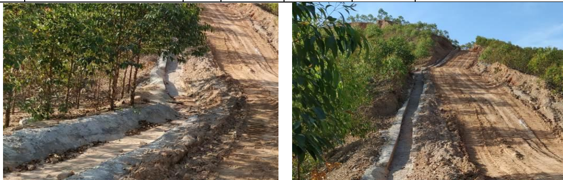
图 4-1 现状浆砌石排水沟照片
