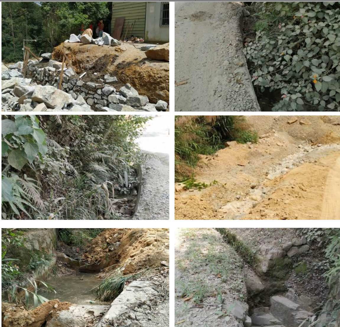
图 3-1 水土保持工程措施照片
