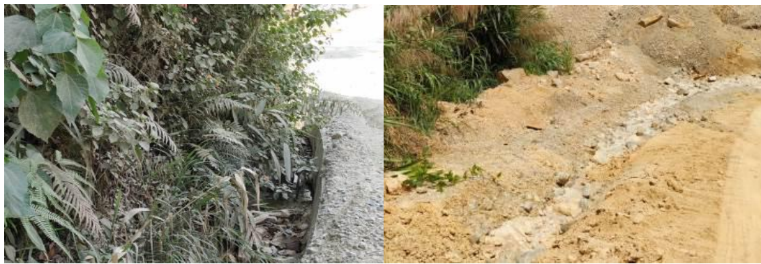
挡土墙、截排水沟、排水沟
