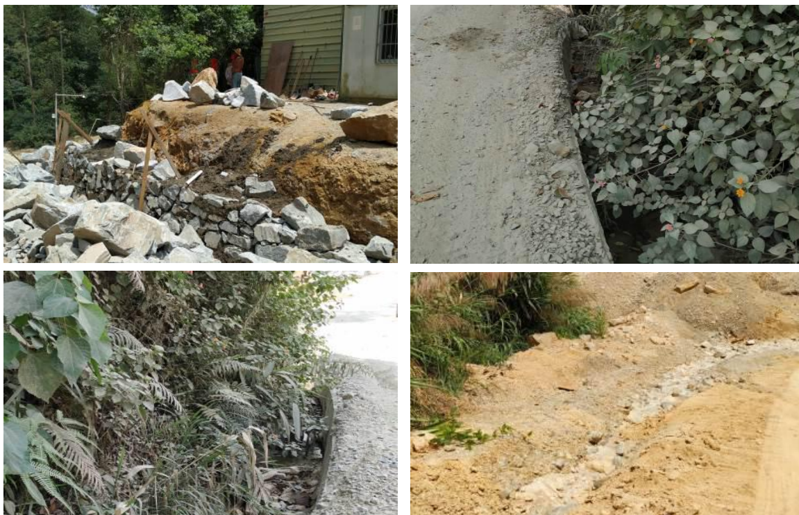
图 4-1 挡土墙、截排水沟、排水沟照片
