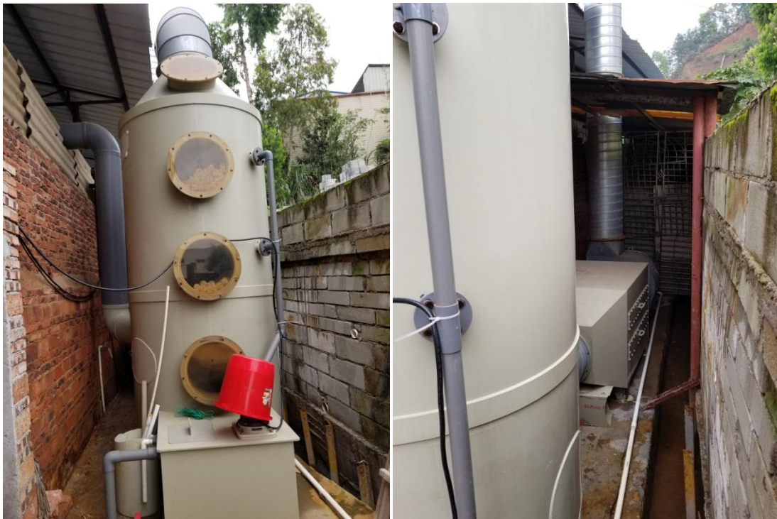
图 4.1-1 “碱液喷淋系统+活性炭吸附”图
