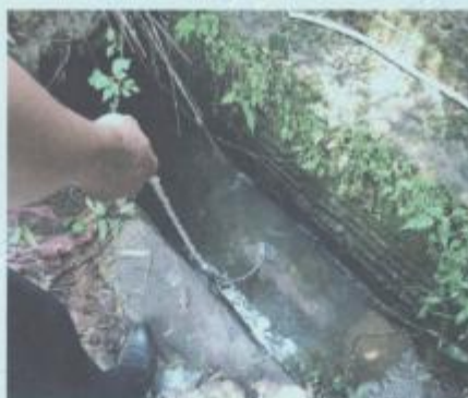
生活污水排放口
