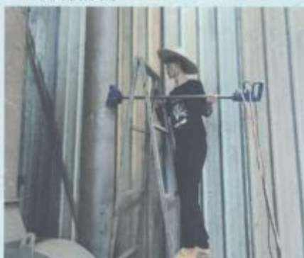
破碎废气采样口（处理前）
