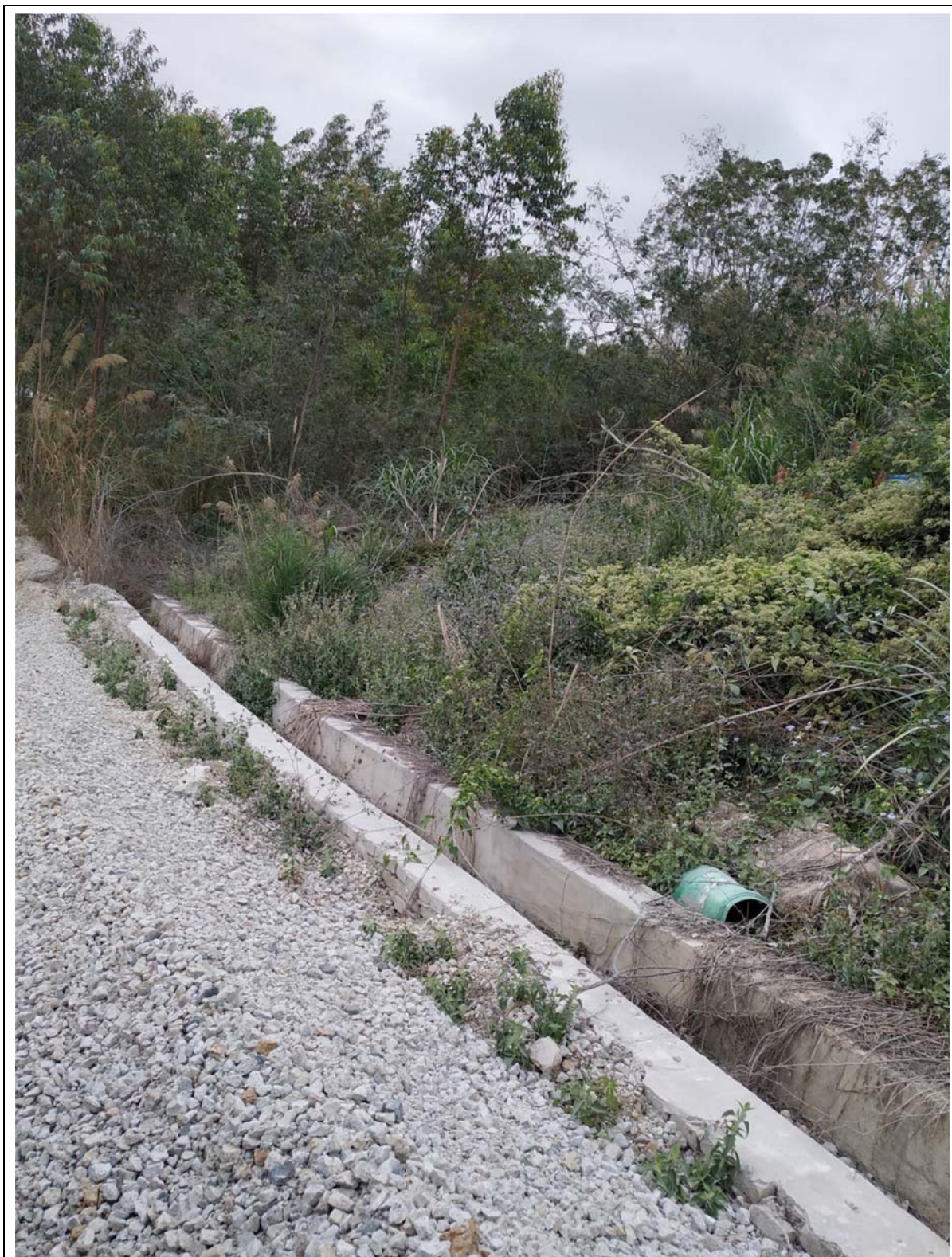
矿山道路排水沟
