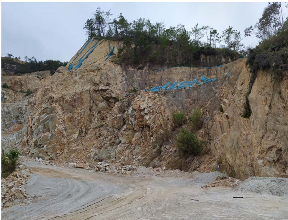
图 3-4 水土保持临时措施照片绿网覆盖
